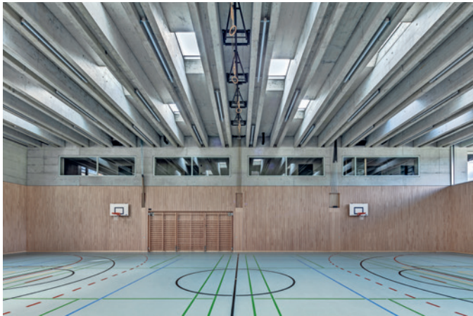
Die Oberlichter fluten die darunterliegende Sporthalle mit Tageslicht.
