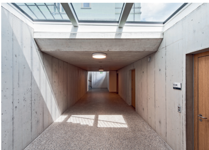
Die Oberlichter der Schule Töss sind befahrbar und erfüllen trotz grosser Glasflächen enorme statische Anforderungen: Flächenlast von einer Tonne pro Quadratmeter.
